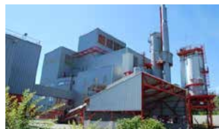
Le CVE de Douchy-les-Mines chauffe environ 1 500 logements
